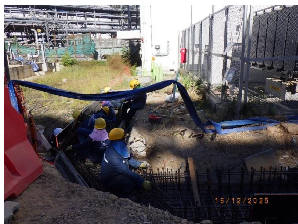
รูปที่ 1-3 งานก่อสร้างรางระบายน้ำ
