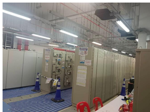
รูปที่ 1-7 งานติดตั้งอุปกรณ์ภายในห้อง Substation
