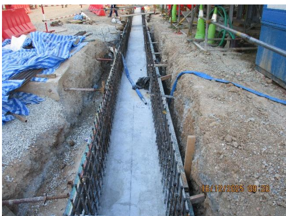
รูปที่ 1-3 งานก่อสร้างรางระบายน้ำ
